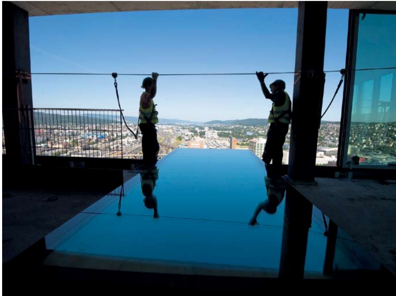
Arbeiter im Prime-Tower in Zürich: Baufirmen setzen auf Technik oder soziale Kontrolle, um Schwarzarbeiter fern zu halten..
